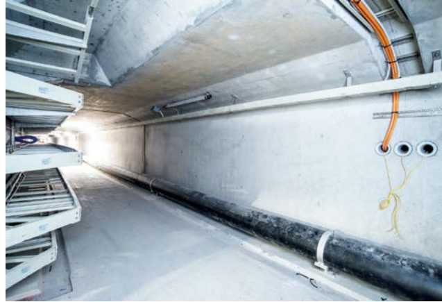
Fig. 5 Wärmedämmte duktile Gussrohre DUCPUR im Werkleitungskanal
