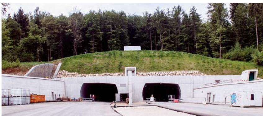
Fig. 1 Ansicht Portalbereich Tunnel Längholz
