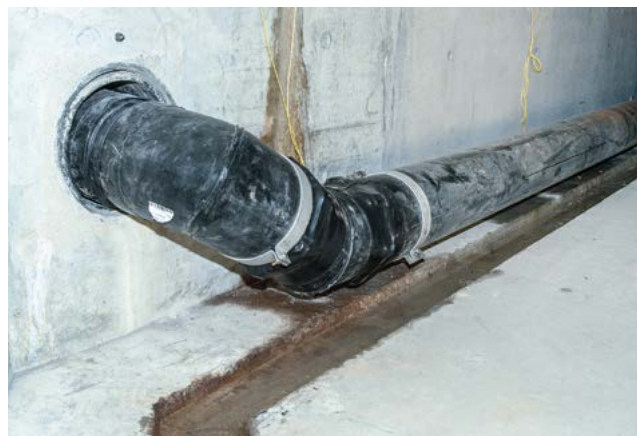
Fig. 7 Nachdämmung mit Schrumpfmanschetten bei den Stossstellen der Steckmuffen
