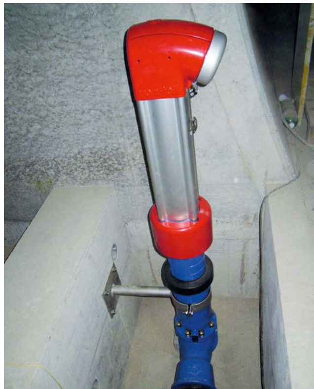
Fig. 14 Hydranten-Unterteil von Roll VARIO 2.0 und Hydranten-Oberteil von Roll HYTEC nach der Endmontage
